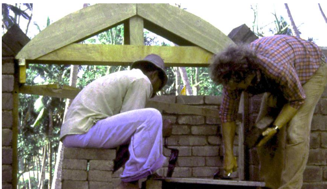
Figure 3. Photo du chantier de Passamainty (CRA Terre, 1982)
