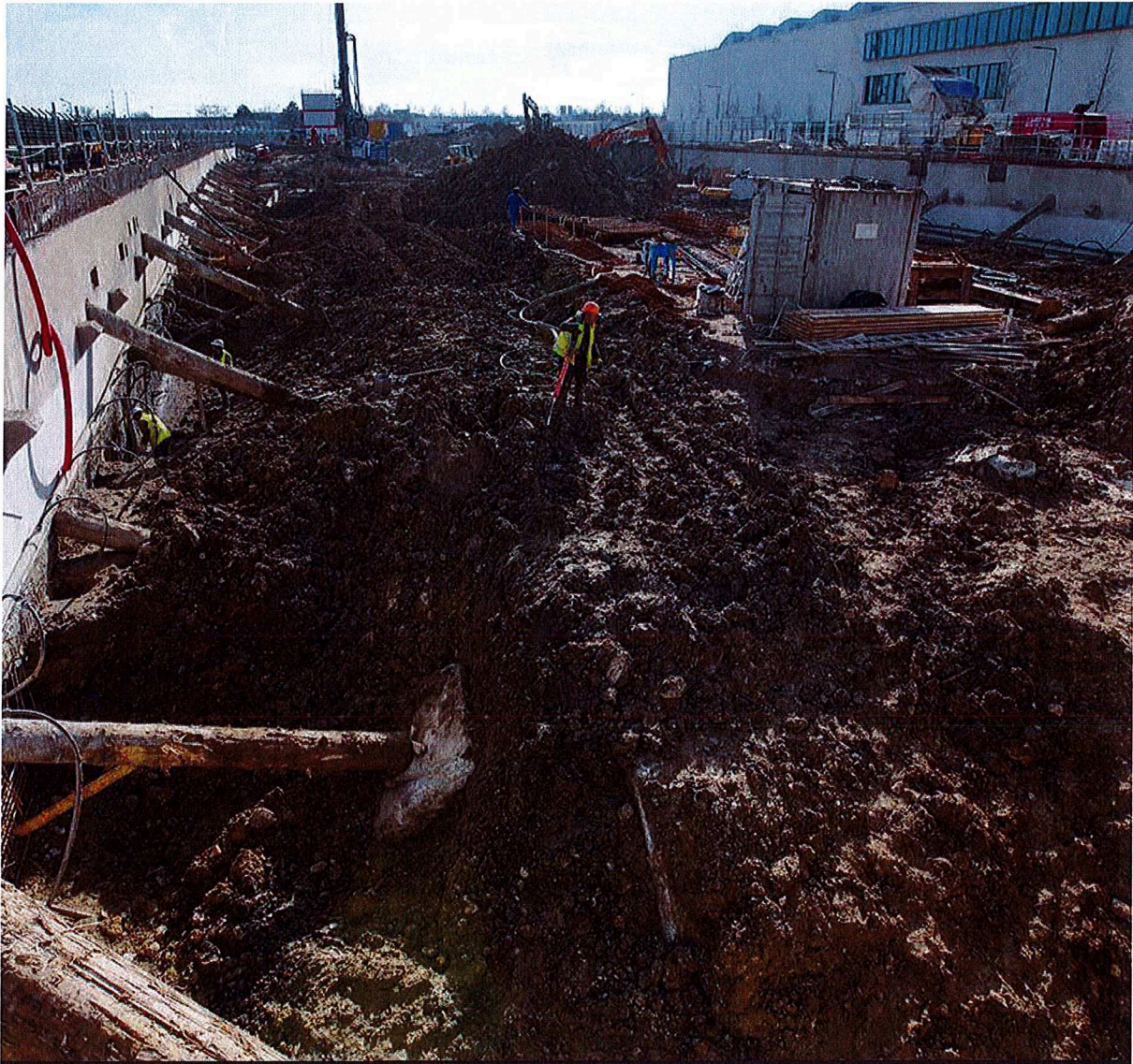
Démarrage des fondations de grue
