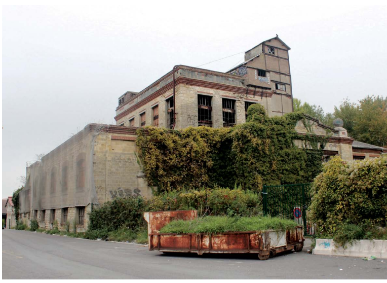
LA DISTILLERIE EN 2015 (FAÇADE SUD ET OUEST)
