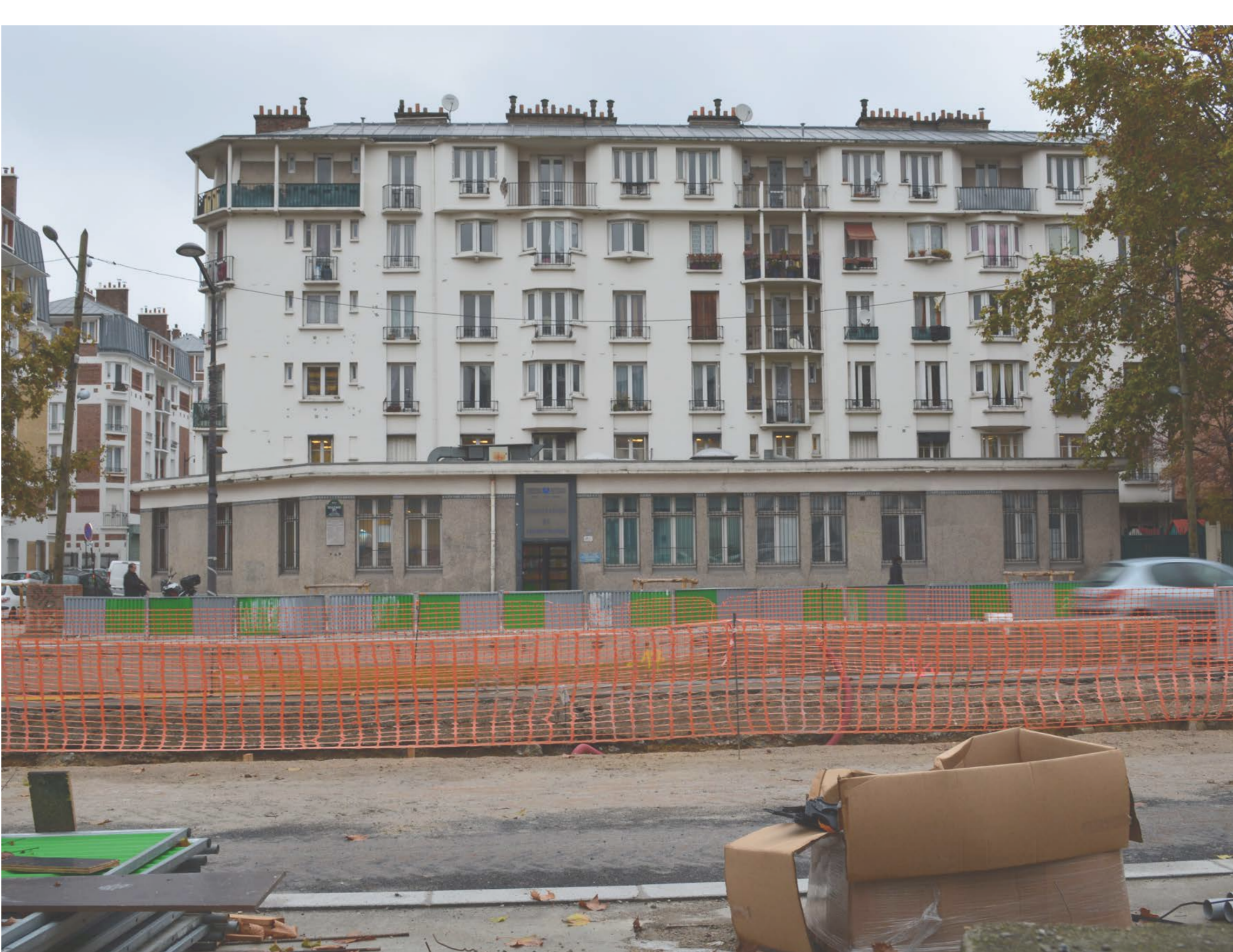
Façade sud de l'existant
