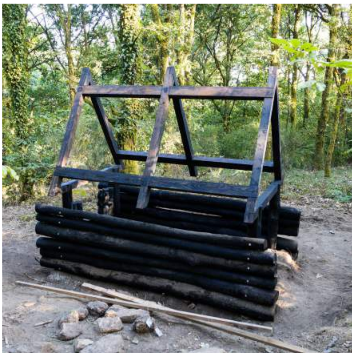
Montage de la charpente
