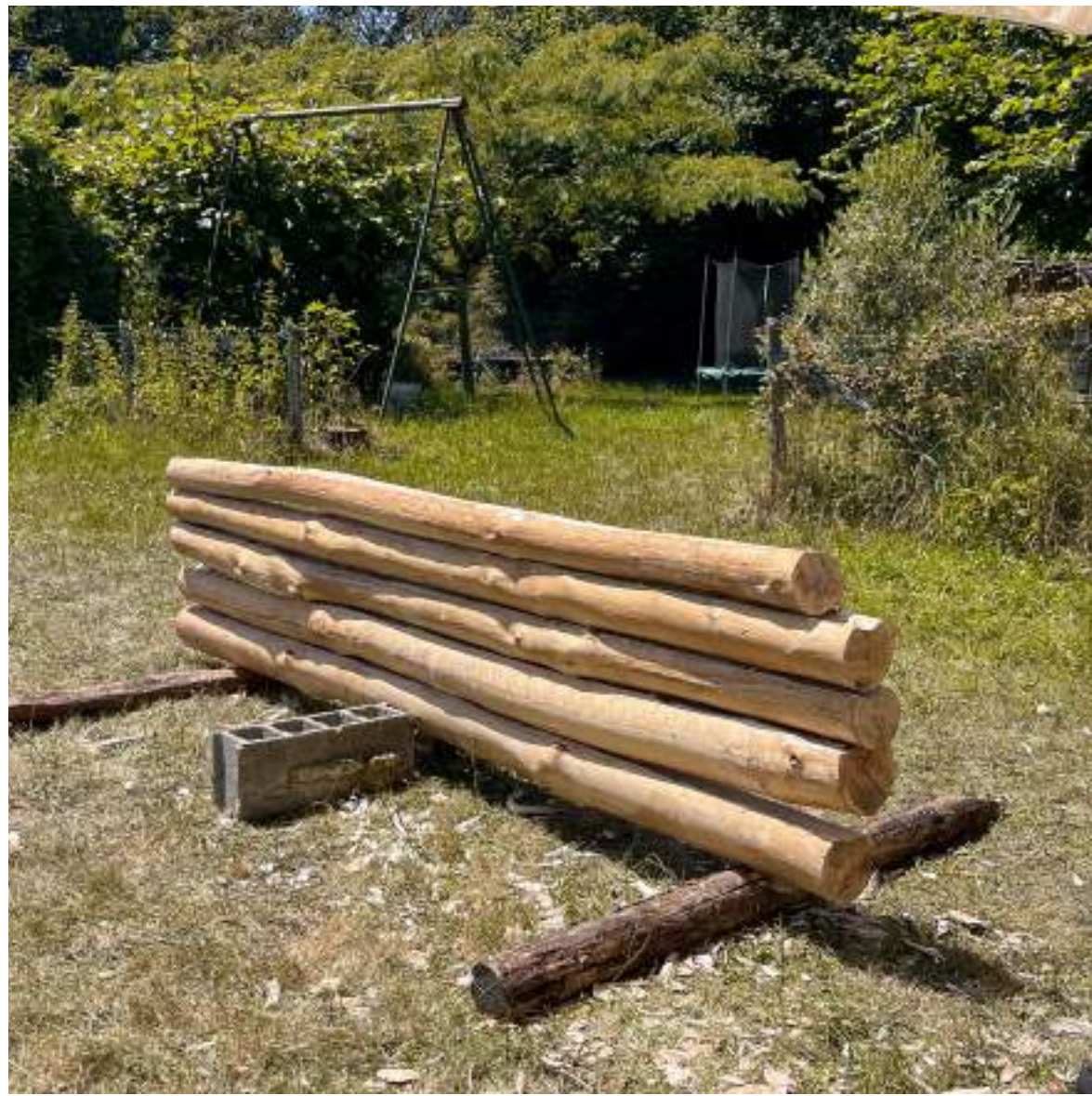
Montage des parois
