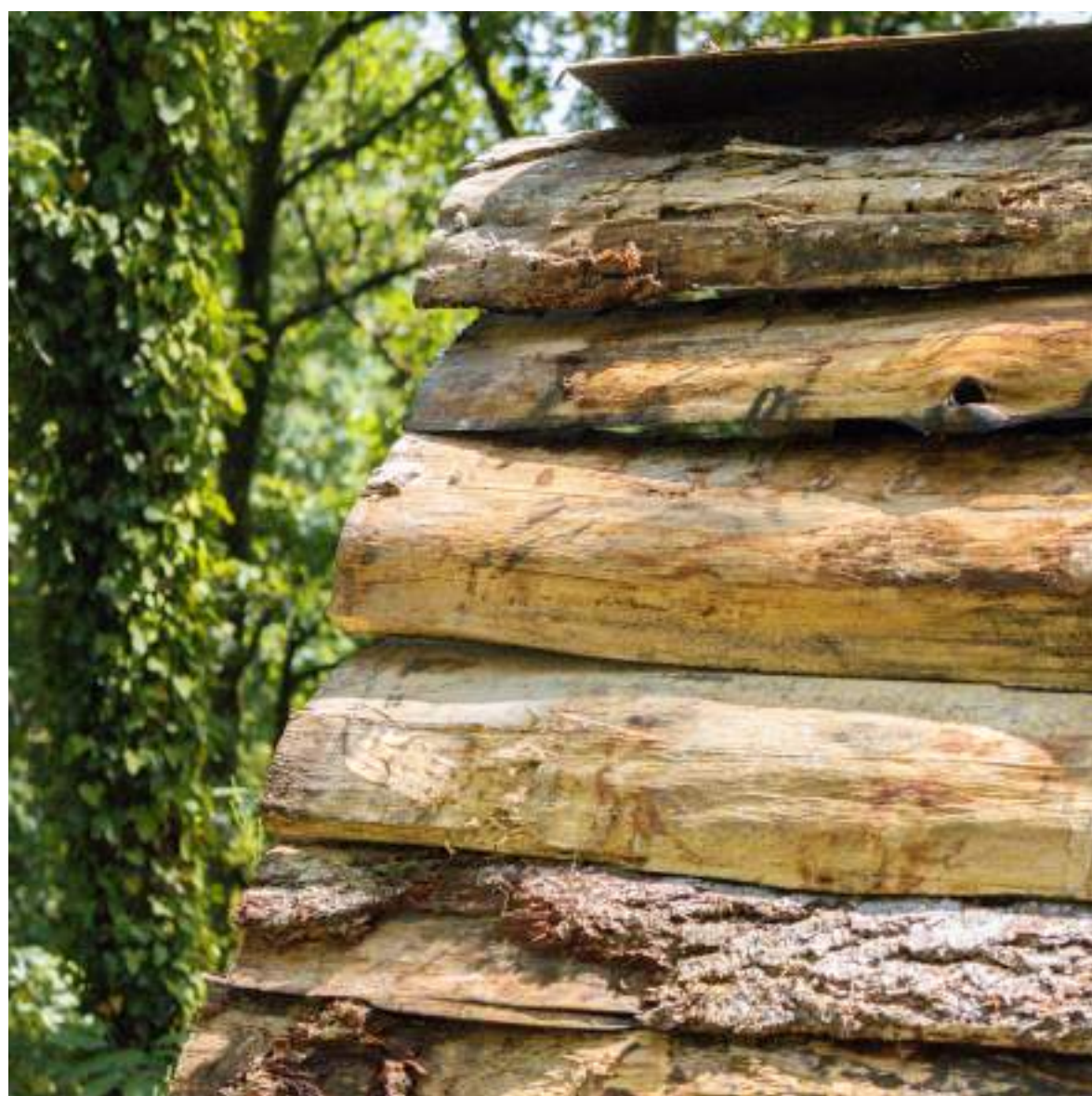
Pose des dosses
