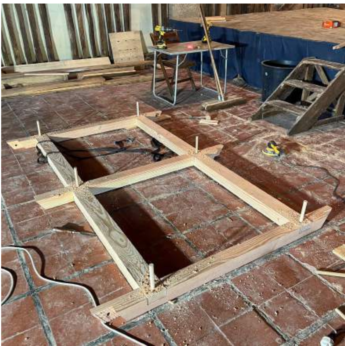
Fabrication de la charpente
