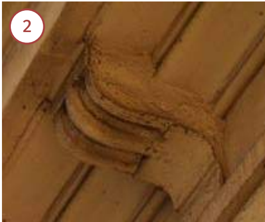
Modillons altérés
