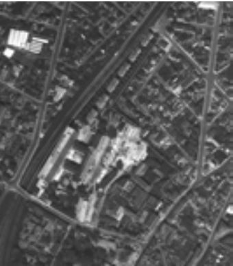
1960 Première grande campagne de travaux
