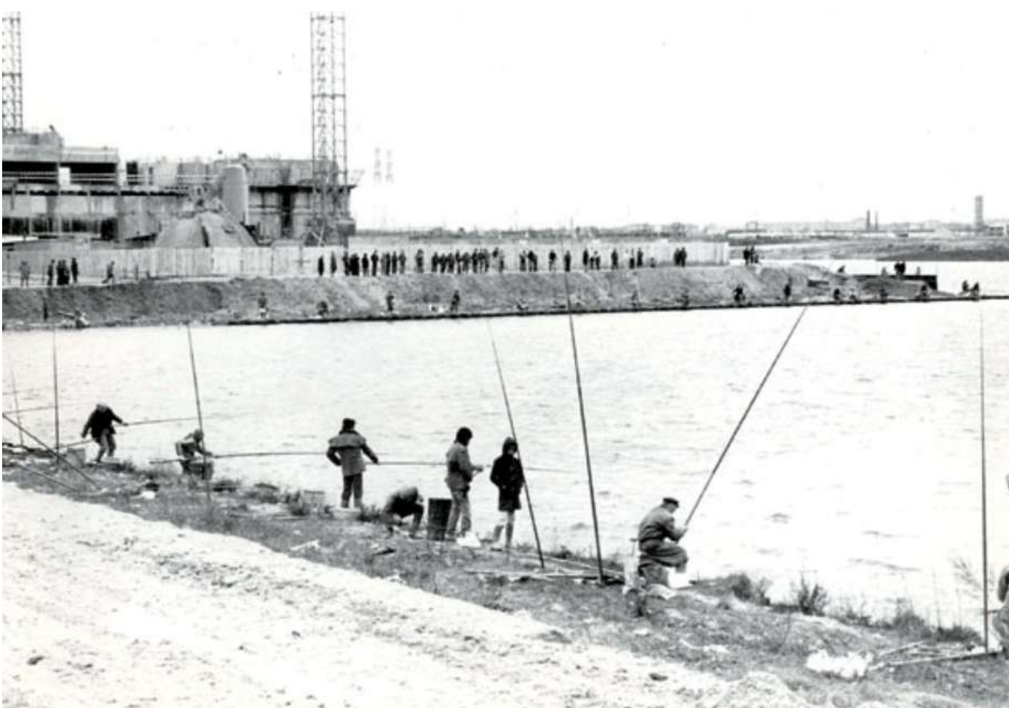
NOUVEAU CRÉTEIL, UN CENTRALITÉ UNIVERSITAIRE, RÉSIDENTIELLE, ADMINISTRATIVES, CULTURELLE, ....
