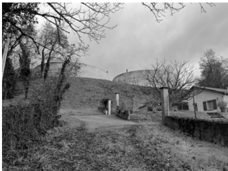
Chemin de la Frairy et vue réservoirs, photographie 2025
