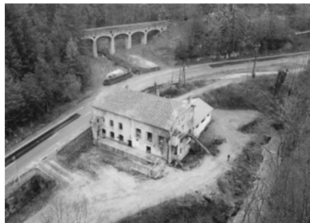
Le moulin et l'aqueduc, photographie aérienne 2018
