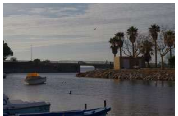
Accès au quartier côté Sud Ouest
