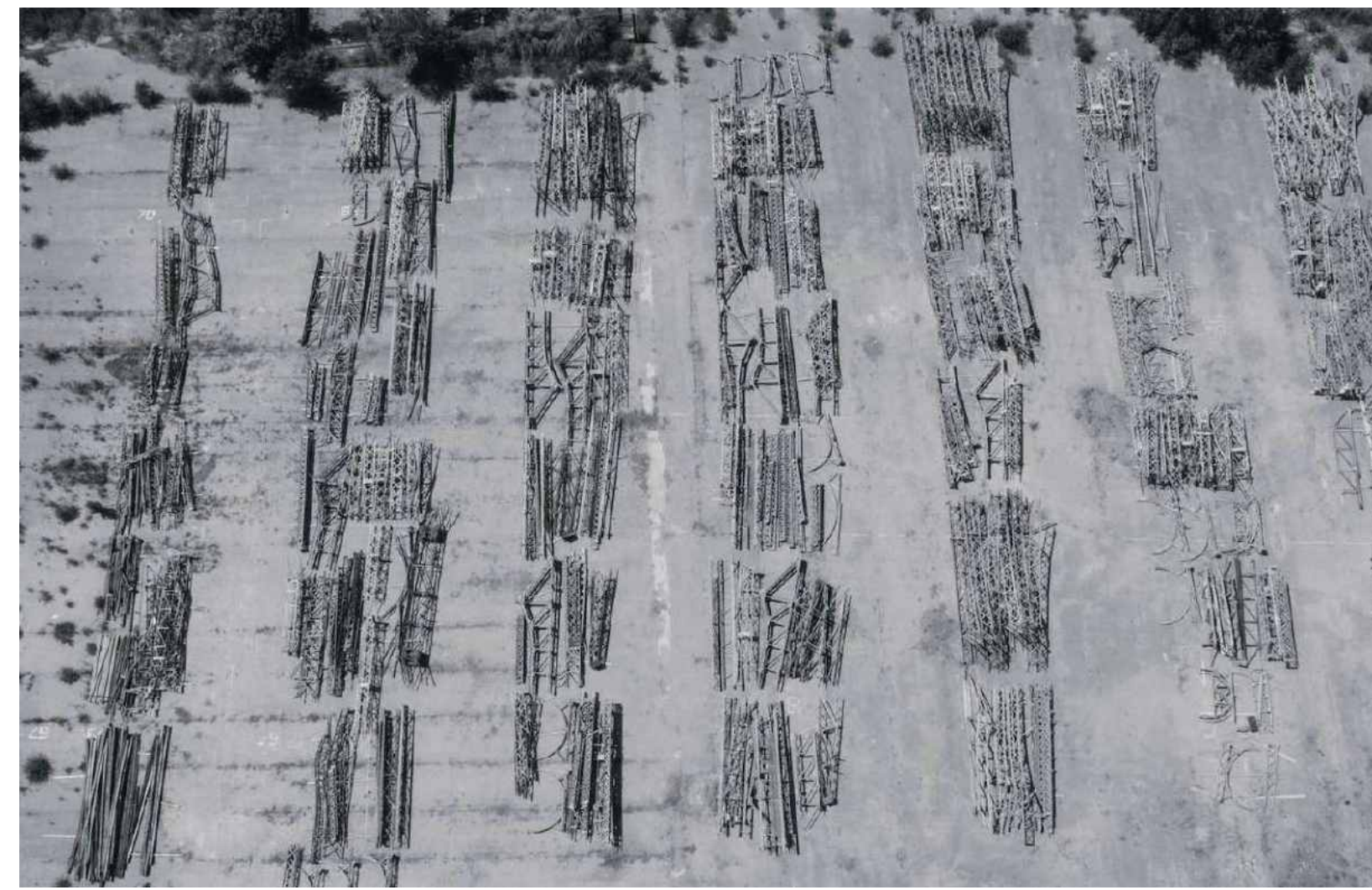
Vestiges de la Halle Édouard Allar_ Structure métallique de l'exposition coloniale de Marseille, laissée à l'abandon à Arles
