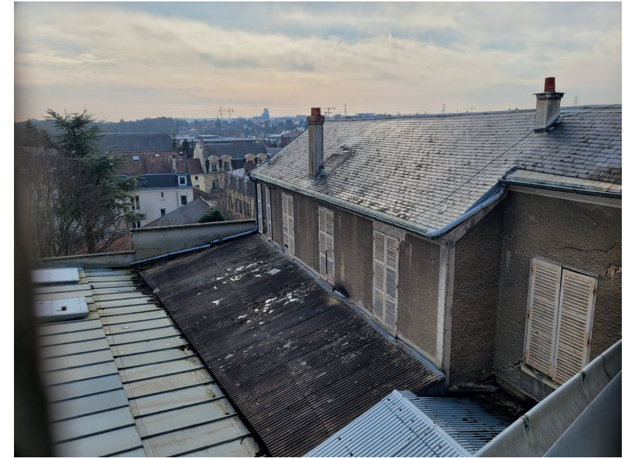
Depuis les combles, panorama sur le sud
