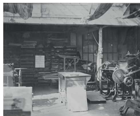
Les machines côté rue
