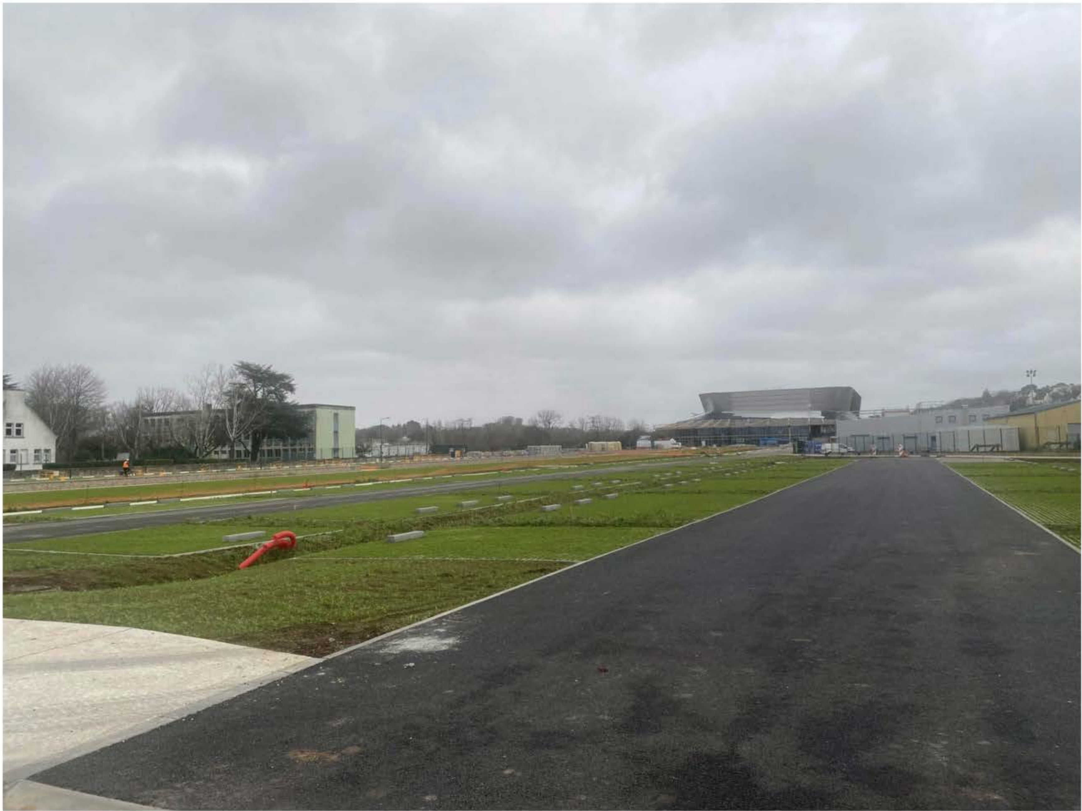
Chantier sur la zone de l'Hippodrome
