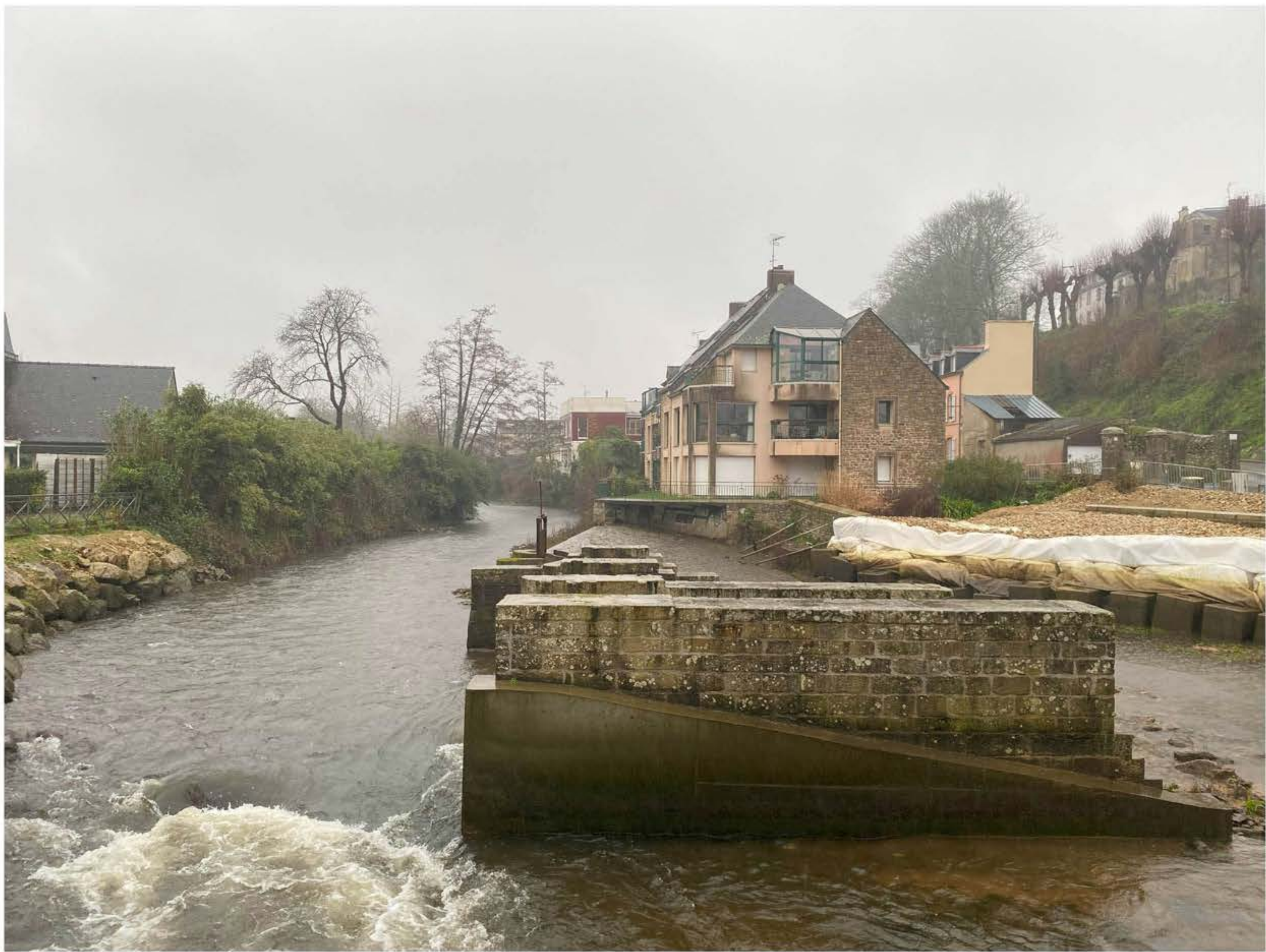
Barrage sur le Steir
