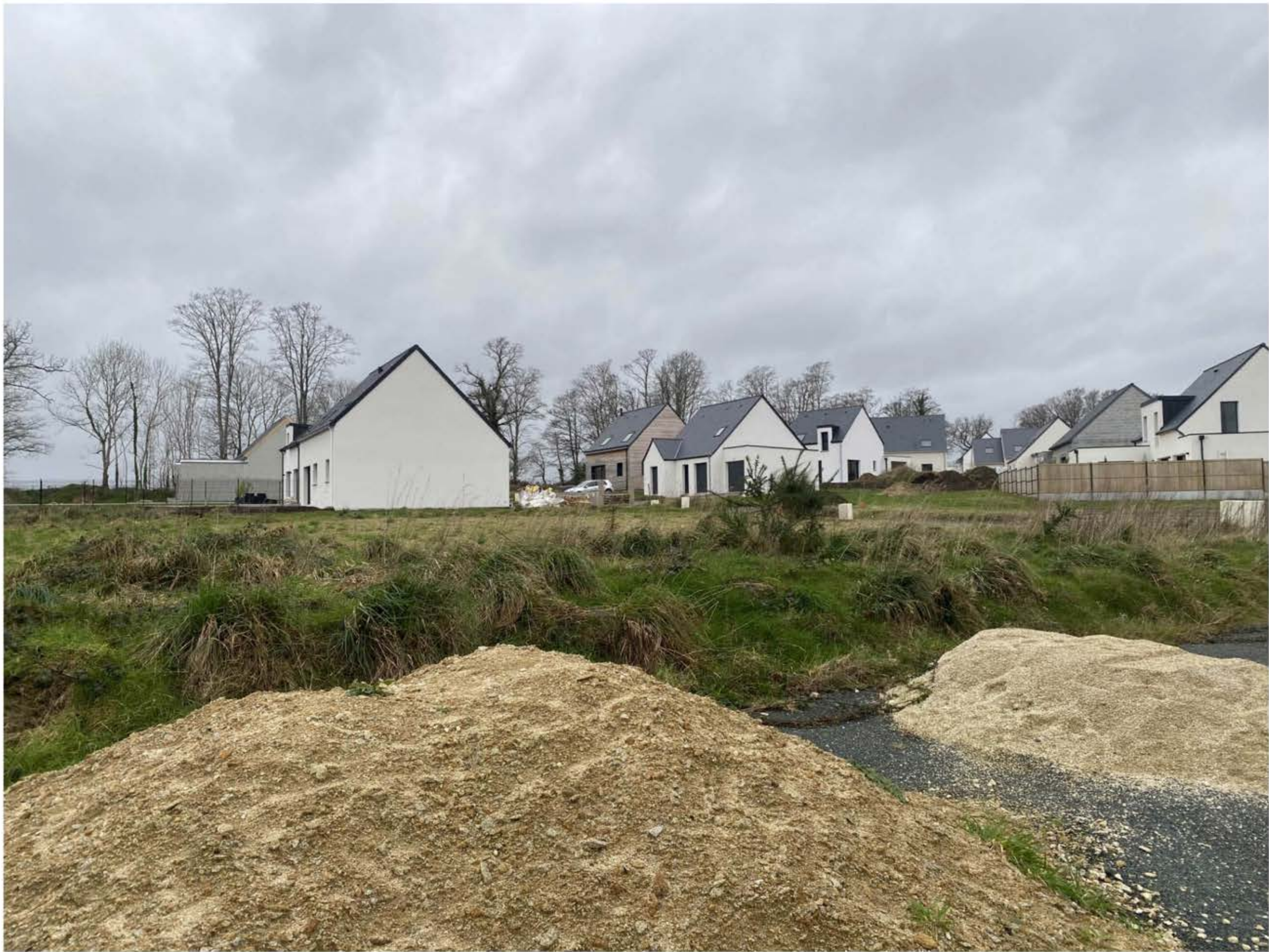
Rue du phare d'Armen - Création d'un quartier pavillonnaire
