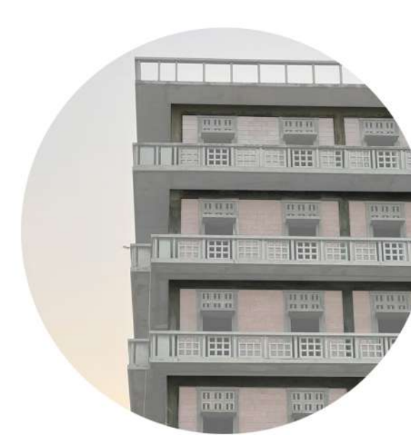
4 - Ossature en béton
