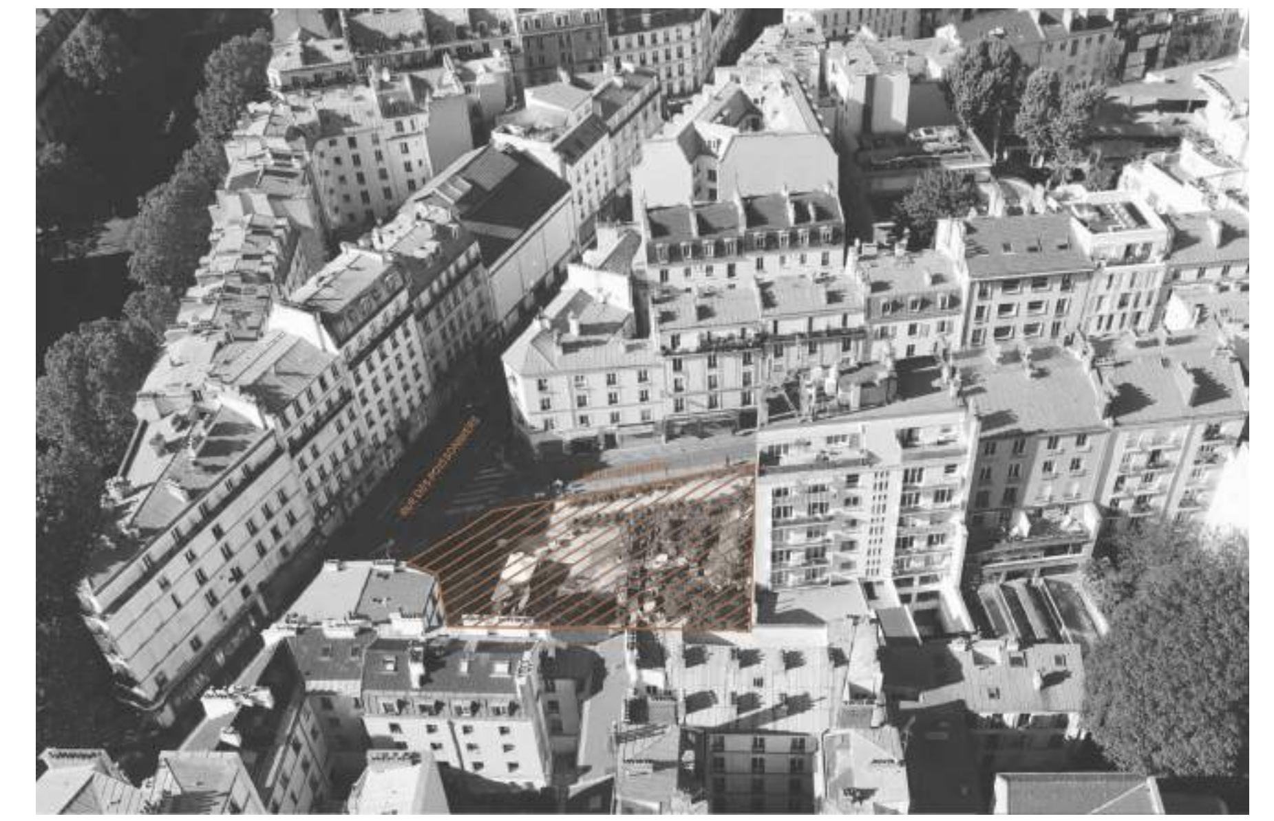
VUE AÉRIENNE DE L'IMPLANTATION DU PROJET ©Collectif friche Polonceau
