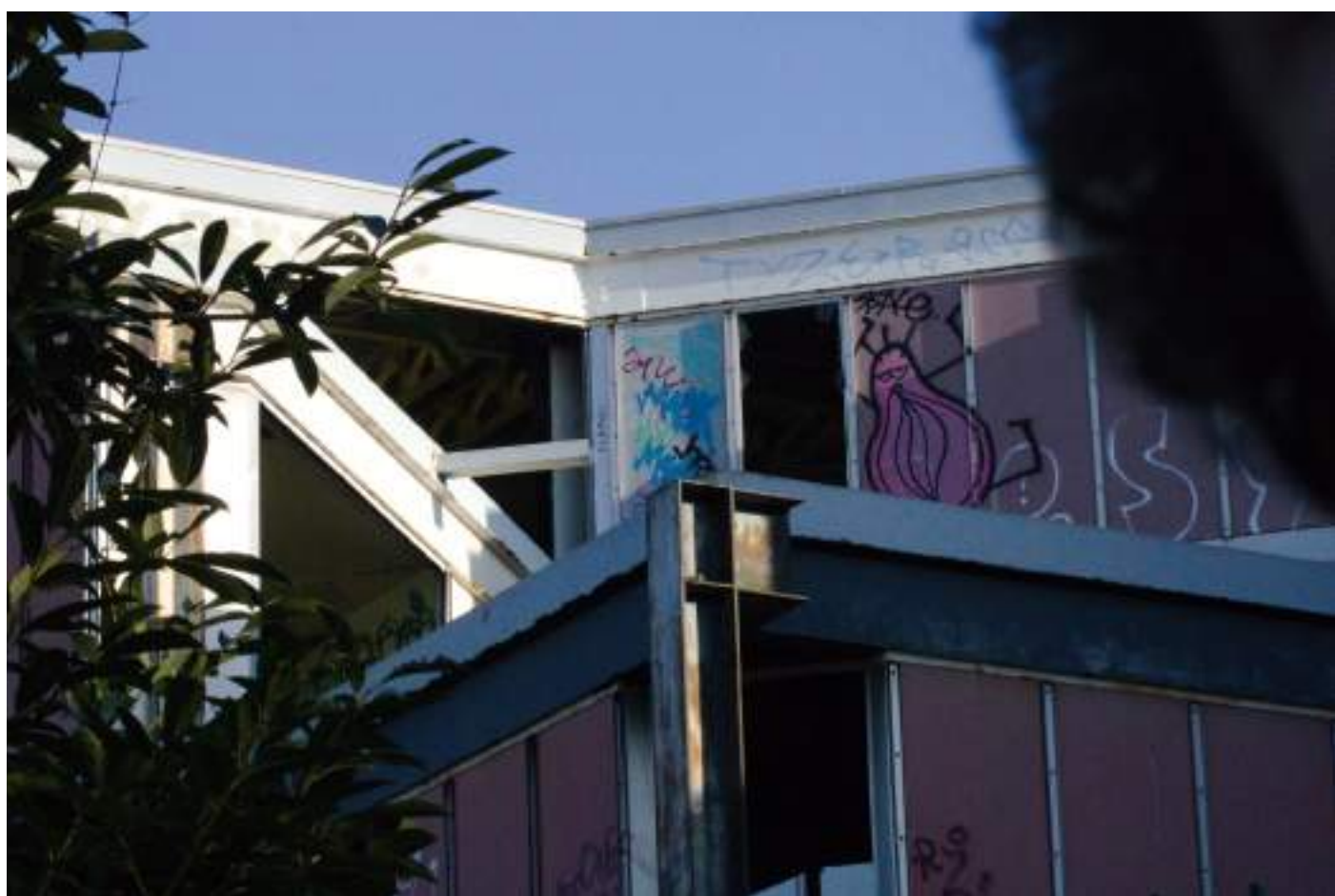
Fig. 20 - Vue éloignée (haut) et très rapprochée (bas) de l'école d'architecture depuis l'allée du Corbusier (photos personnelles)
