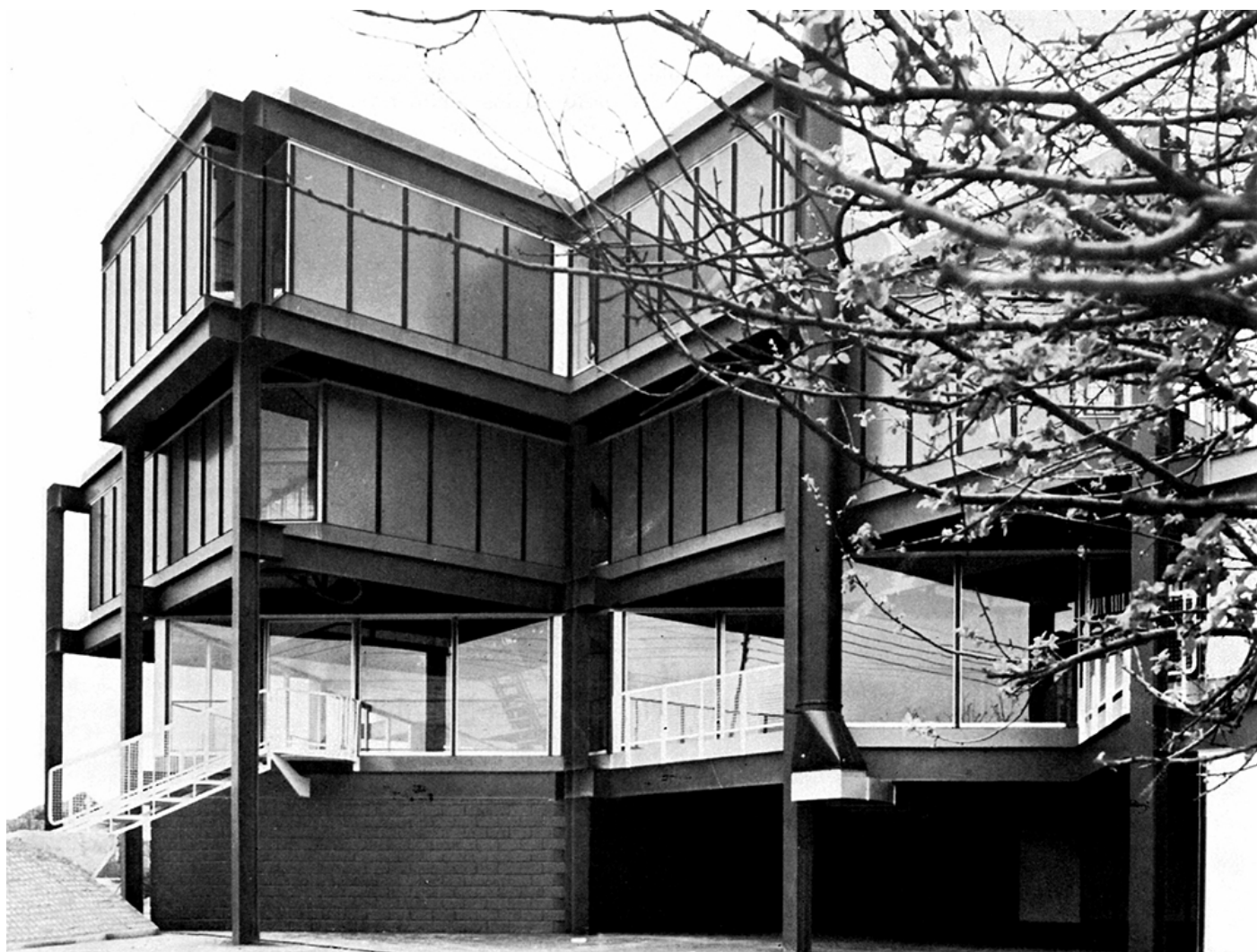
Fig. 6 - Vue aérienne (haut) et de l'extérieur (bas) de l'ancienne Ecole d'Architecture Paris - La Défense (Photos, source : fond Jacques Kalisz, cité de l'architecture et du patrimoine en ligne https://archiwebture.citedelarchitecture.fr/fonds/FRAPNo2_KALJA )
