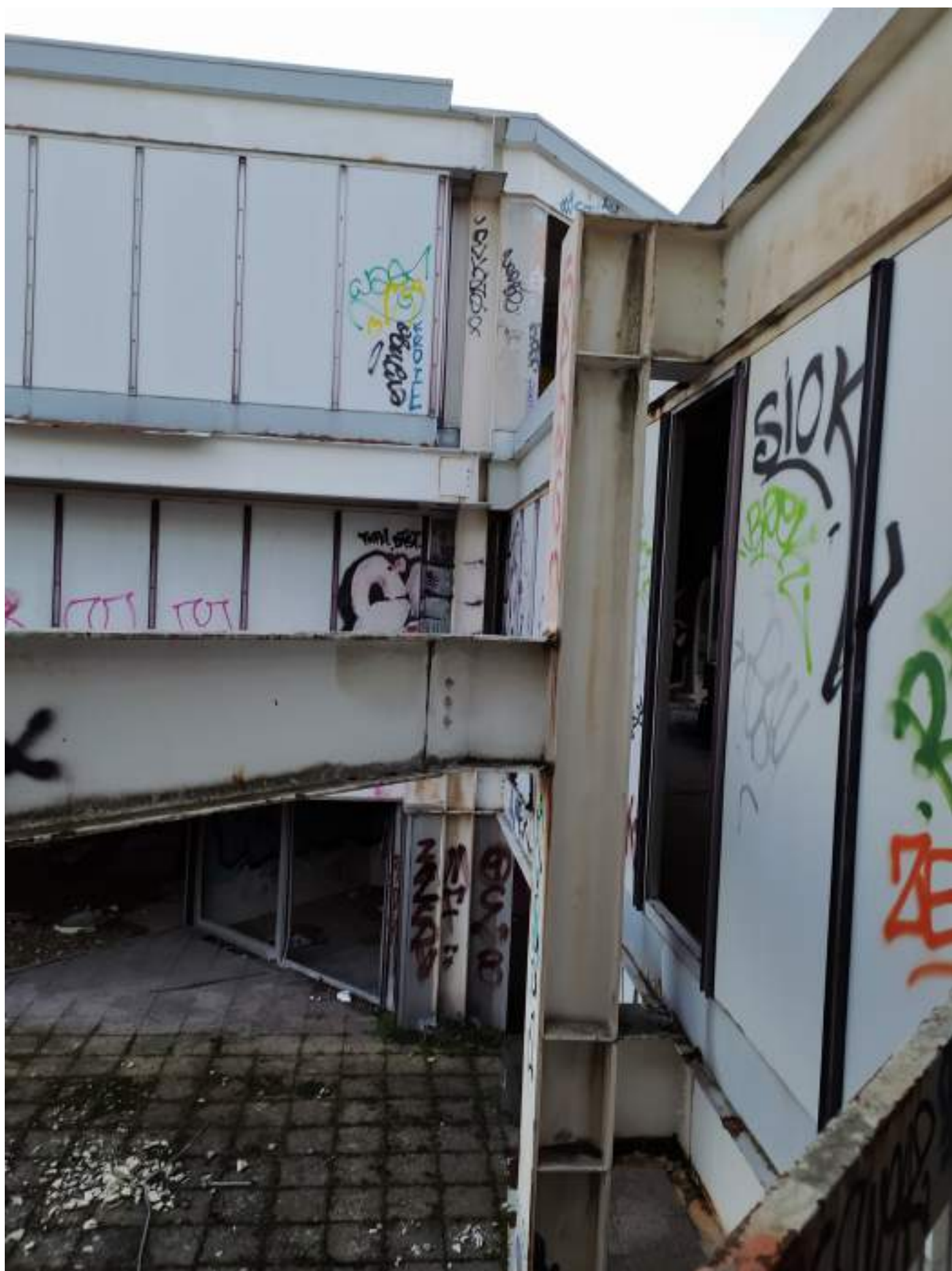
Fig. 18 - Vue rapprochée d'un poteau depuis les escaliers de la terrasse du R+2 (photo personnelle, 08 janvier 2021)
