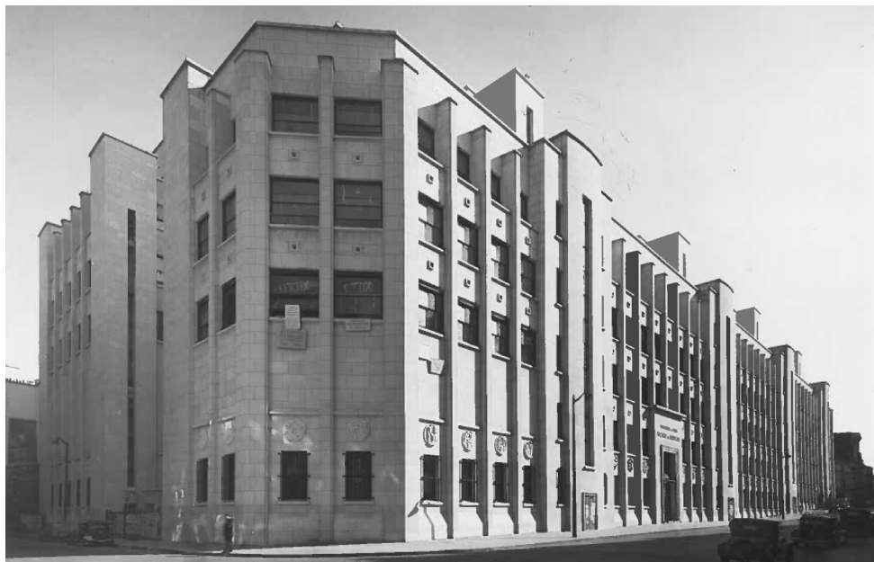
Vue du bâtiment de l'angle rue Jacob et rue Saints-Pères (© CHEVOJON)
