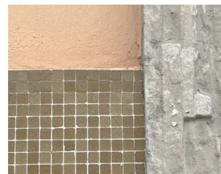
Matériaux originaux des bâtiments des années 70
