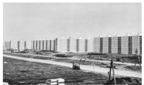
Chantier du district Avtozavodski, 1969
