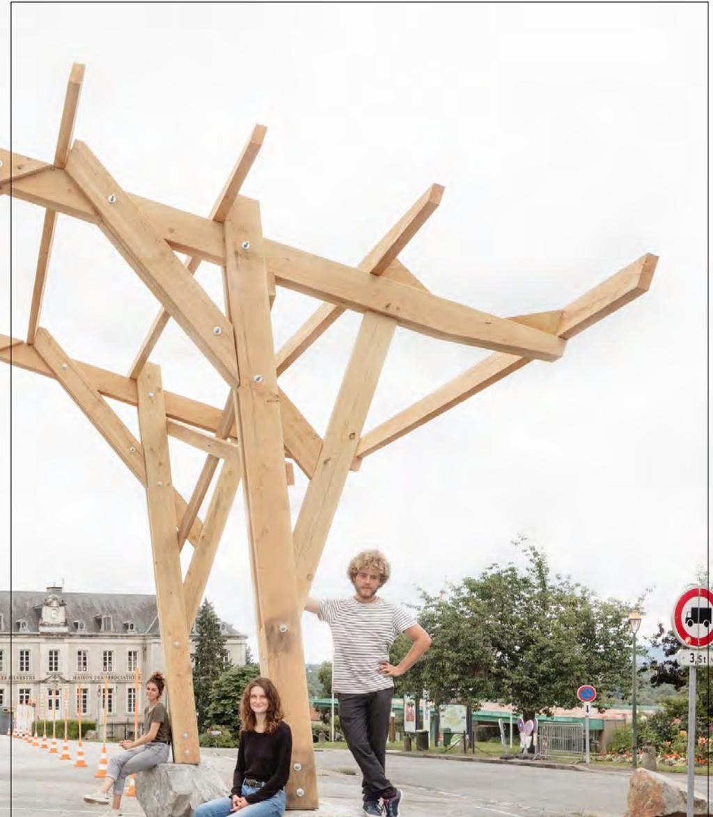
Conception et construction d'un prototype échelle 1 d'une trame de portiques pour le nouveau marché de Bellac. 2021
